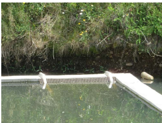
Exemples de dispositifs d'échappatoires à mettre en place – DRYOPTERIS, 2019
