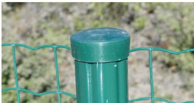
Exemples de dispositifs d'obturation des poteaux – DRYOPTERIS, 2017
