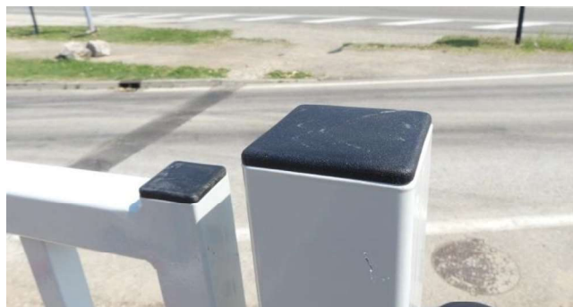
Système d'obturation de poteaux - Source : Conseil général Isère, 2010
