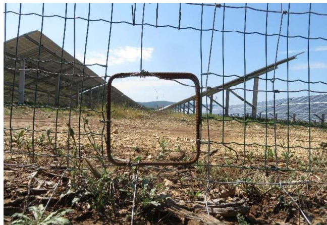
Trouées renforcées créées sur une clôture – DRYOPTERIS, 2018
